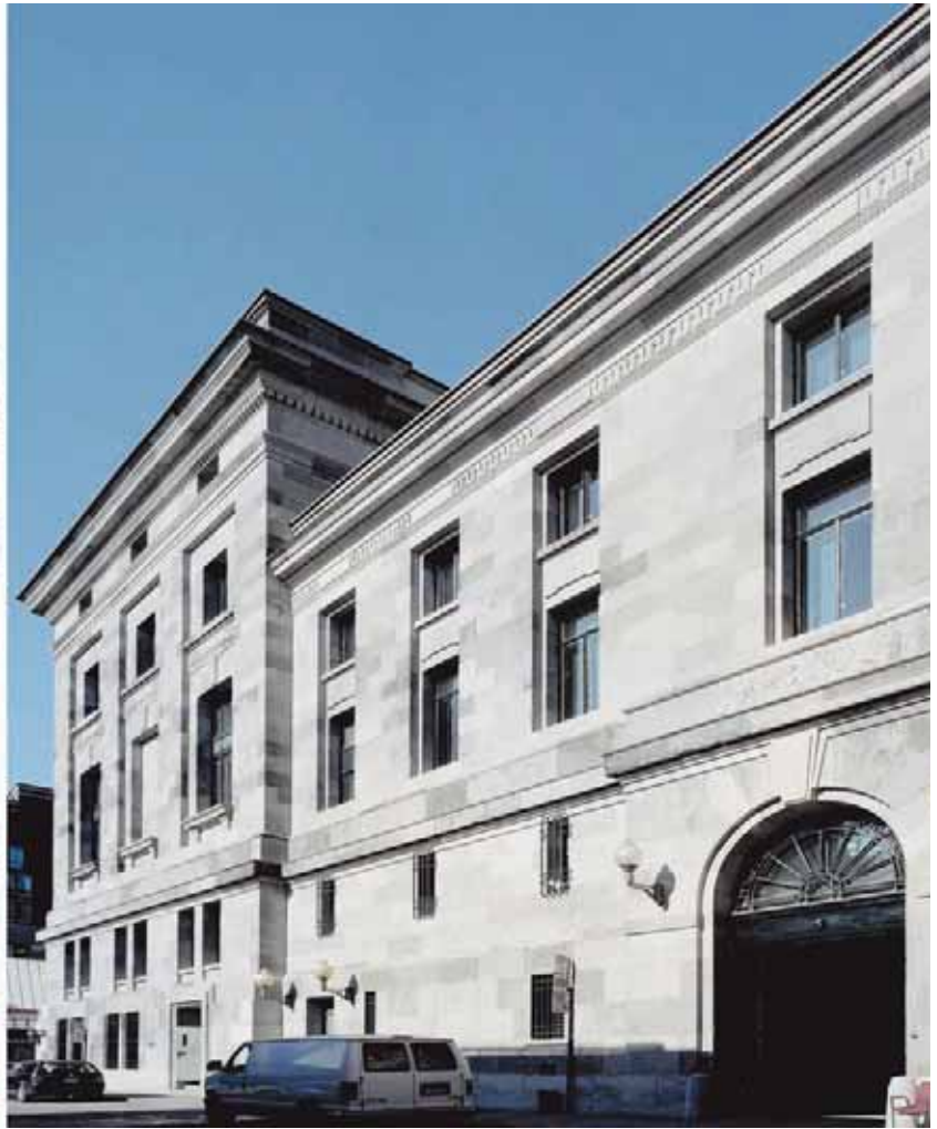
La réfection de la Cour d'appel : un défi de taille en milieu urbain
